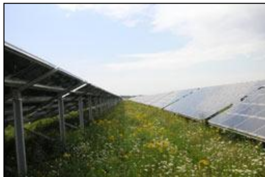
Abb. 13: Beispiel „Aufgeständertes Modulfeld“
