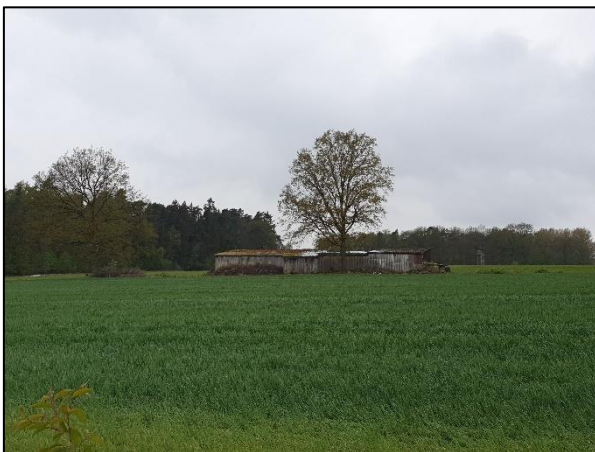
Abb. 3: Zentrale Scheune im Geltungsbereich
