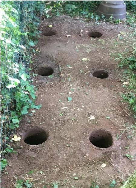
Löcher bohren  $\varnothing$  20 cm /  $\updownarrow$  60 cm
